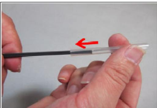
3) 将保护套管插入到光缆中。
